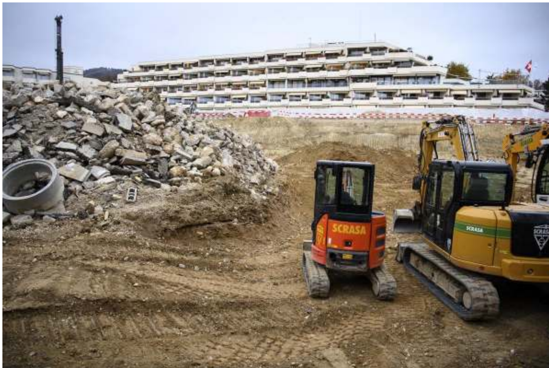
Le chantier du futur bâtiment du Genolier Innovation Hub, devant la clinique de Genolier. KEYSTONE/Laurent Gilliéron
