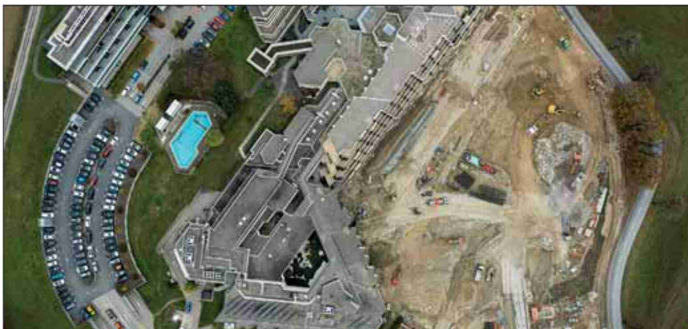
Le début d'un grand chantier: l'ouvrage sera livré à l'automne 2023.
