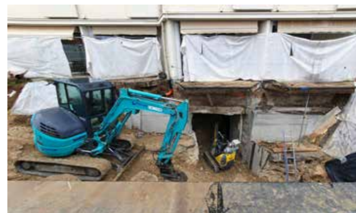
Hub et clinique seront reliés par plusieurs passages. Depuis le toit végétalisé, un ascenseur haut d'une dizaine de mètres permettra d'accéder à une passerelle vitrée longue de 20 m. Un autre accès entre les deux entités – réservé aux équipes techniques – est également en cours de construction : un microtunnel de 28 m, large de 2,5 m et haut de 2,3 m.
